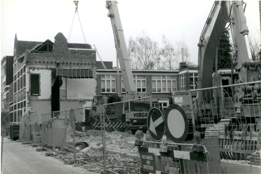
Afbraakwerken van het oude gebouw in 2000.
