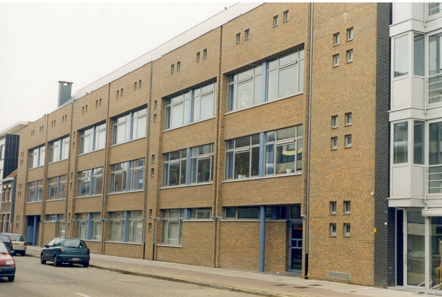
De voltooide nieuwbouw in 2002.
